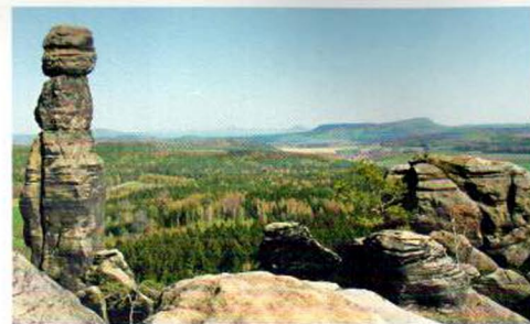
Der höchste Bereich der Kletteranlage aus Spritzbeton in der Potsdamer Waldstadt II ist der Felsnadel „Barbarine“ in der Sächsischen Schweiz nachempfunden.
